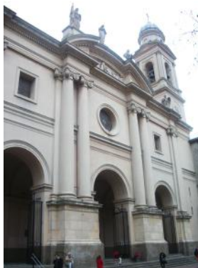
Fig. 47 Detalle de la fachada. Tres arcos de medio punto marcan el acceso al pórtico. A cada lado de la entrada central se levantan dos columnas de orden colosal rematadas con capiteles jónicos, y a los lados de las entradas laterales, dos pilastras también de orden colosal y con capitel jónico.
